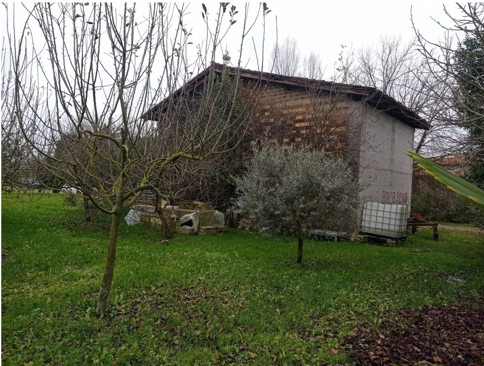
Foto 4 – Vista del fabbricato da nord
