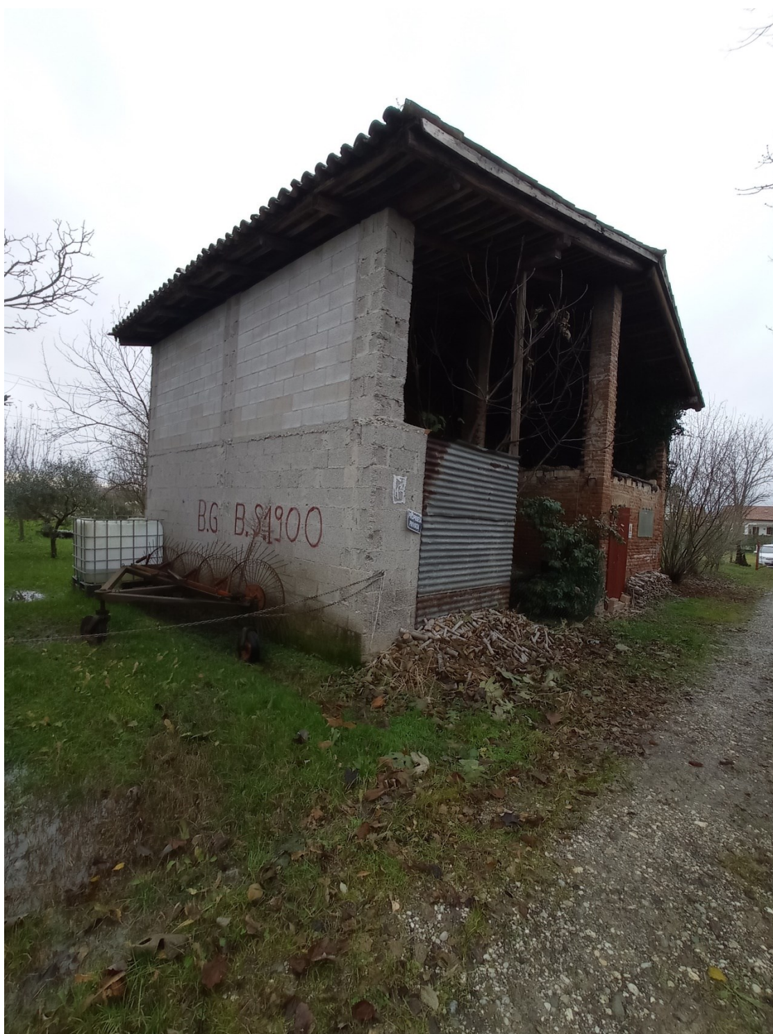
Foto 2 – Vista del fabbricato sud-ovest
