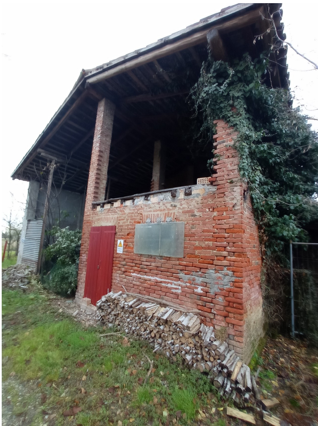
Foto 3 – Vista del fabbricato da sud
